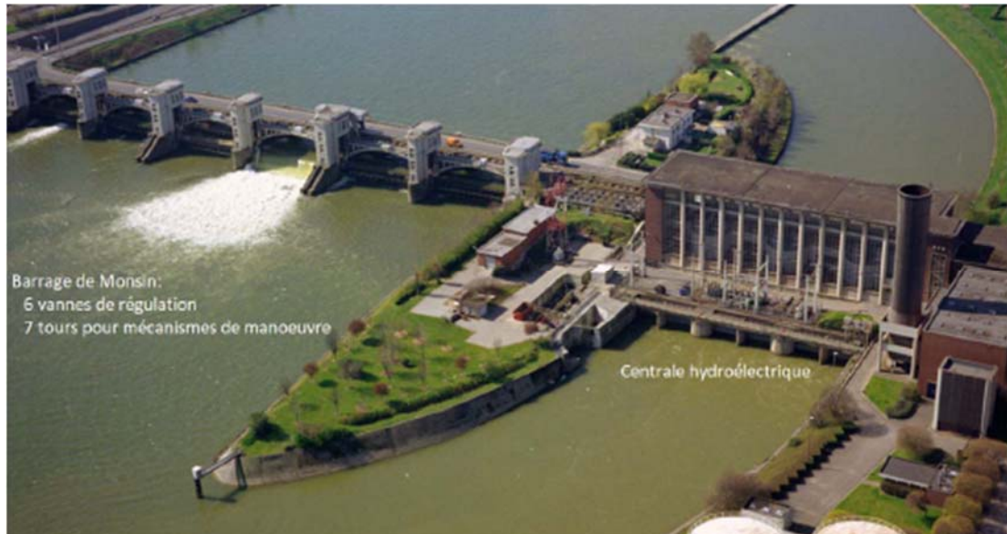
Figure 5-55 : Barrage de l'île Monsin
