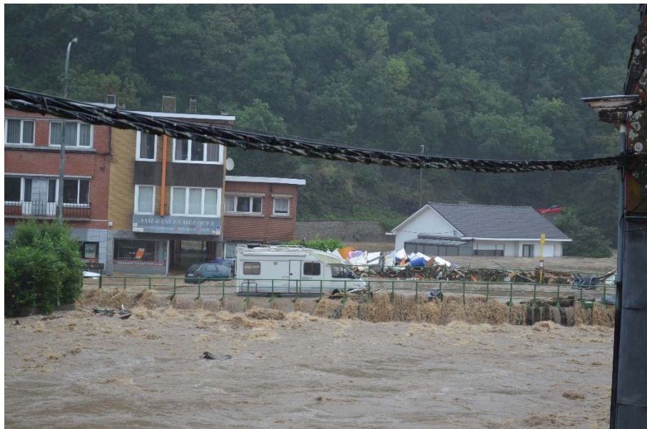
Figure 5-40 : Embâcle sur le pont de Prayon à Trooz
